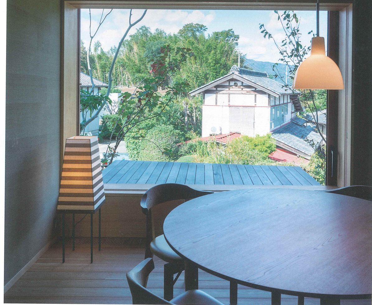
ダイニングからテラス越しに景色を望む。テラスはFL+380mmに設置し、室内側では腰掛けにもなる。
