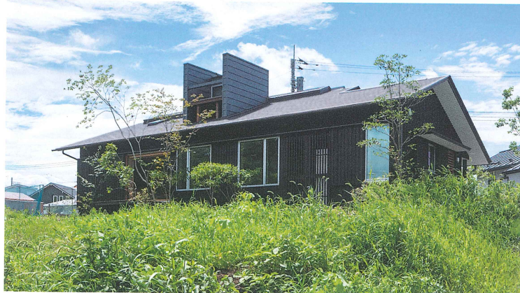
北側外観。屋根には北側に広がる里山の景色を楽しむ物見台を設置している。屋根のメンテナンスにも役に立つ。*
