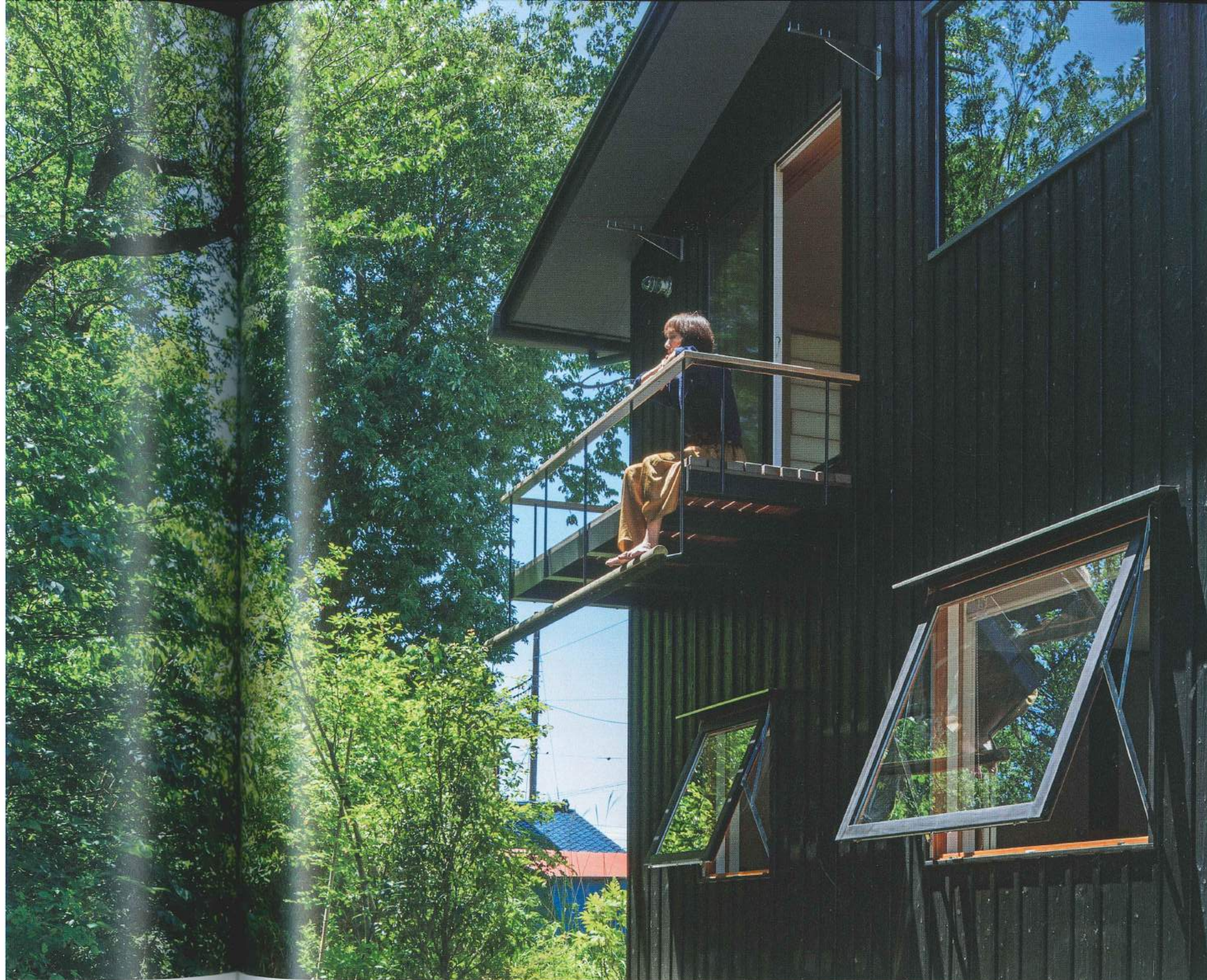
東側近景。畳室のベランダには腰掛けて風景を眺めるため足置きなどの工夫があり、木立の中に浮かぶように過ごせる。手摺りはガラスなども置けるよう、幅を80mmとしている。
