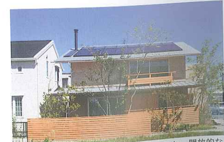
南から見る全景。軒や下屋の高さが抑えられ、開放的な開口部をもつ。屋根にはOMソーラー集熱パネルとOM集熱機能付き太陽電池モジュールを設置。日本的な佇まいのゼロエネ住宅となっている。
