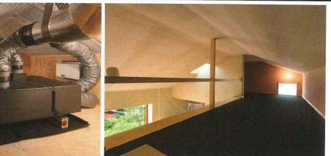
上／奥が設備スペース。6畳程度の空間に納めることができたため、そのほかをロフトスペースとして活用している右／ロフトスペースは吹抜けで下階とつながる。吹抜けを介して空気を循環させてるので、ダクトを長く引っ張る必要がなくなった
