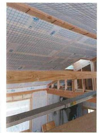
屋根と外壁の断熱は、デコスセルロースファイバーを乾式吹込工法で施工
